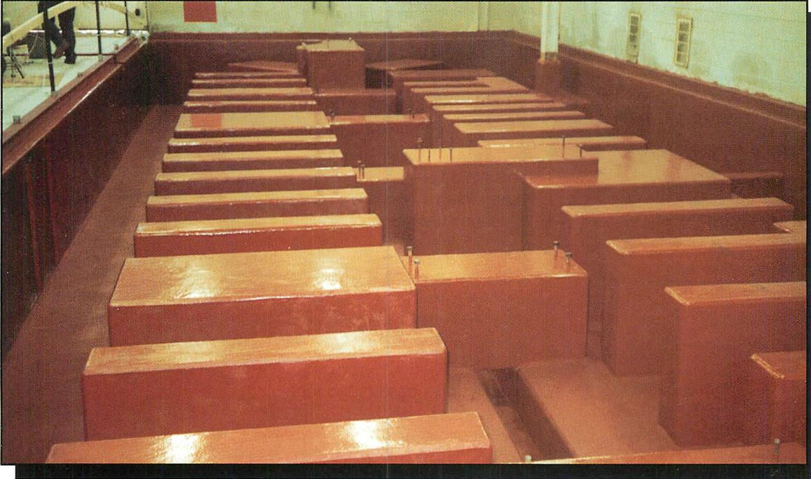
Trincheras forrado con un epoxico que resiste acido, puede aguantar ataque de quimica, acido, alcalino y caustico.
